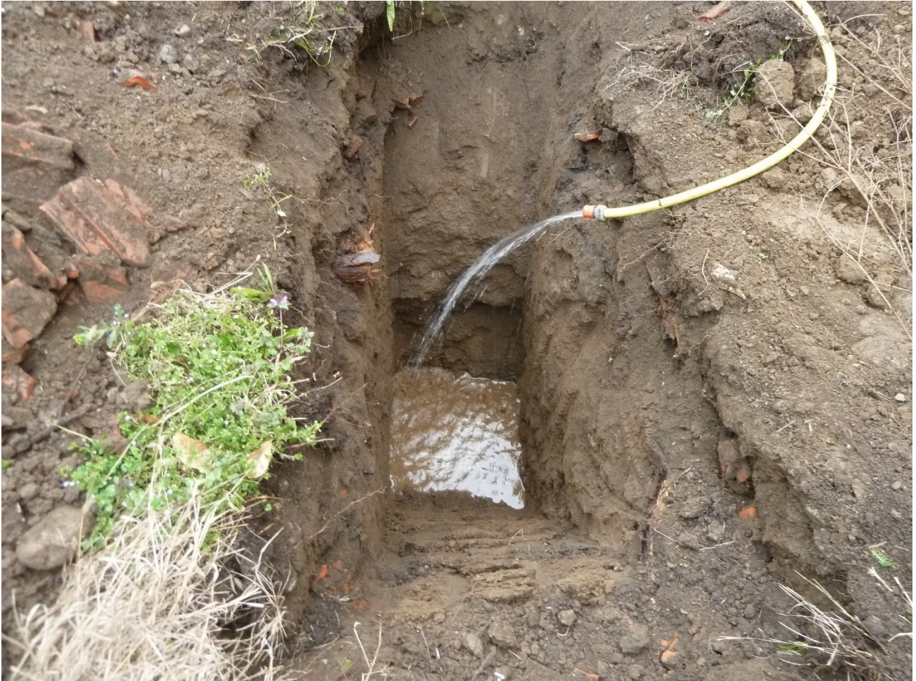
Fig.3: saggio con escavatore e prova di permeabilità;
